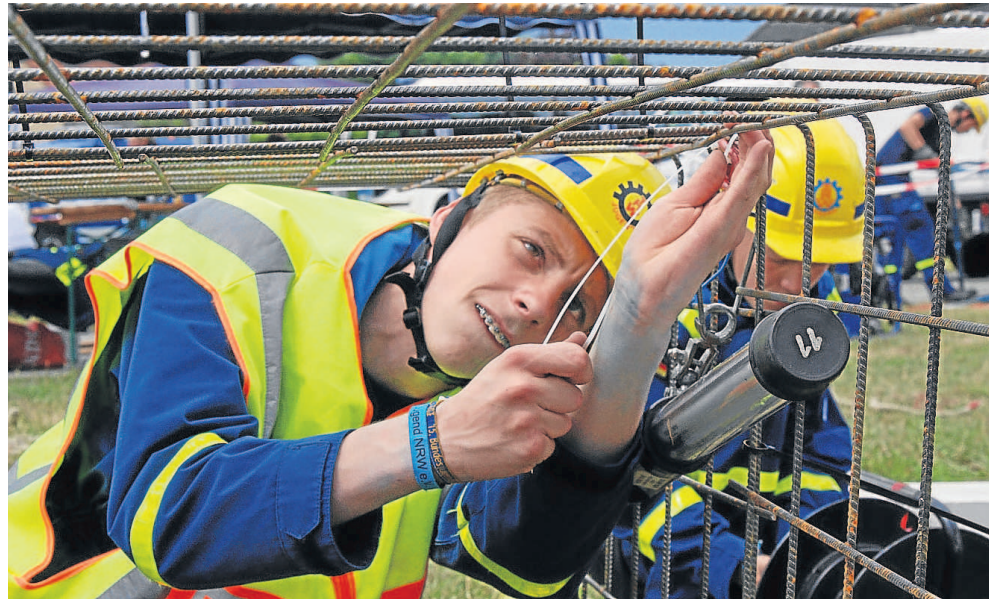
Gruppenführer Niklas Hermes installiert eine Lampe in einem Tunneldurchgang. Foto: Dennis Stein
